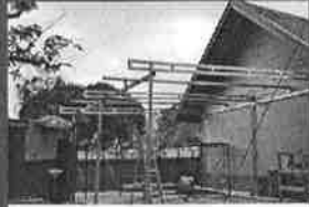
ต่อเติมโรงครัวใหม่ ณ วัดป่าอาจารย์คือ
